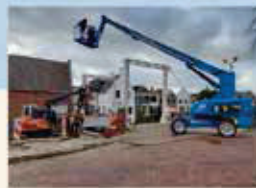
De restauratie van de brug in 2021-2022
