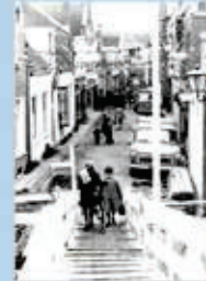
De restauratie van de Vechtbrug in maart 1972.
